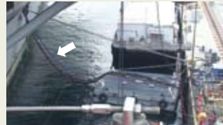
G・ワシントンの外部電源ケーブル
